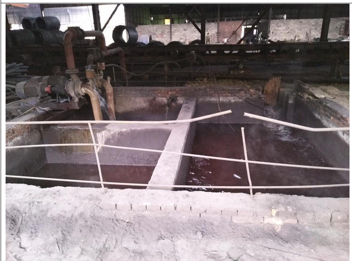
轧钢车间循环水池（2）
