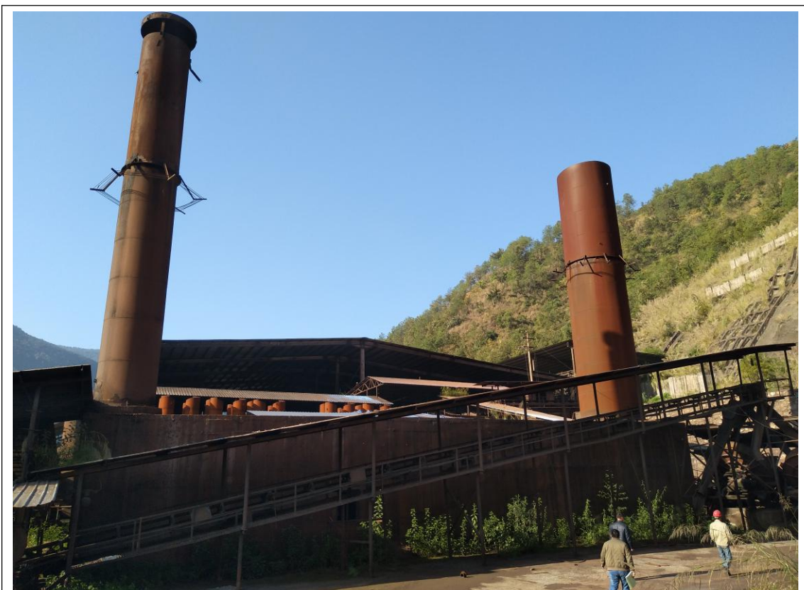
烧结机头、机尾水幕除尘
