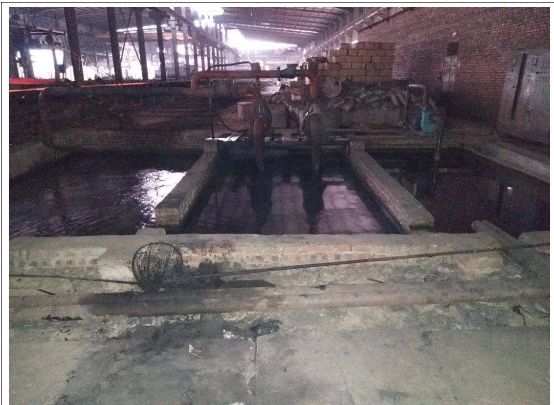
轧钢车间循环水池（1）
