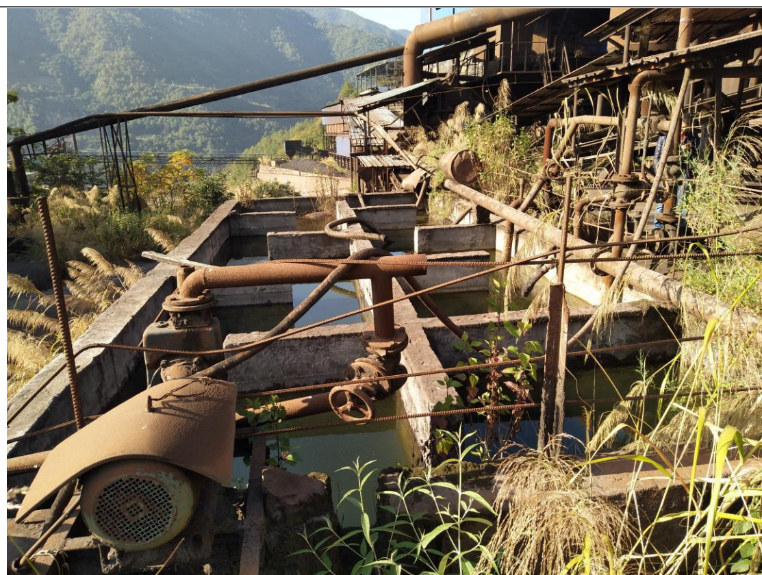
烧结水幕除尘循环水池
